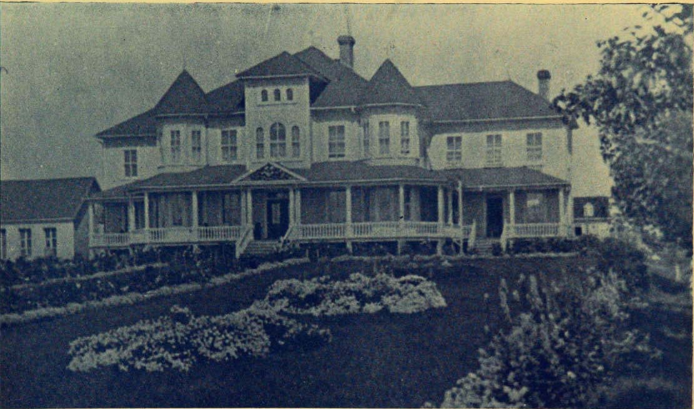
Ancien évêché, presbytère actuel de Havre Saint-Pierre
